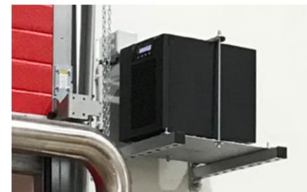
Onduleur pour manoeuvre de secours en cas de coupure de courant
