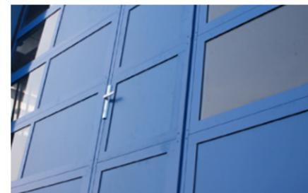
Remplissage en tôles aluminium pleines ou perforées
