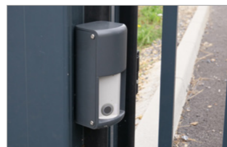
Détecteur de véhicules pour ouverture automatique
